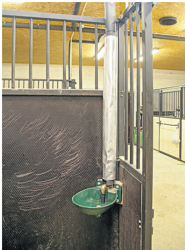
Juomakuppien vesiputkissa on tuplaeristys ja itse kupit ovat lämmitettäviä. Talli on kylmä, mutta sen saa tarvittaessa lämpimäksi lattiasa olevilla vastuksilla.
